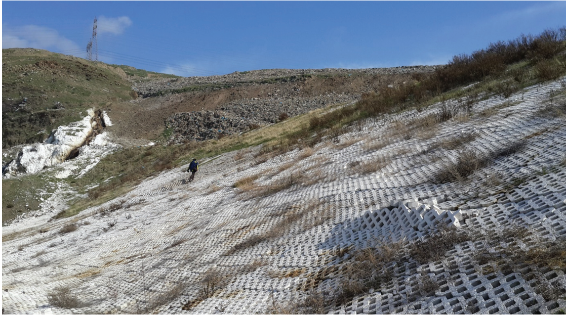
Şekil 15. Sedde üzerindeki kabarmalar.
